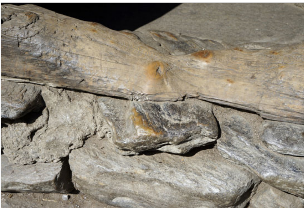
Abbildung: 56 Über Jahrhunderte abgetretene Türschwelle auf der Mitterkaseralm (1954 m). Foto: F. Mandl, 2012.
