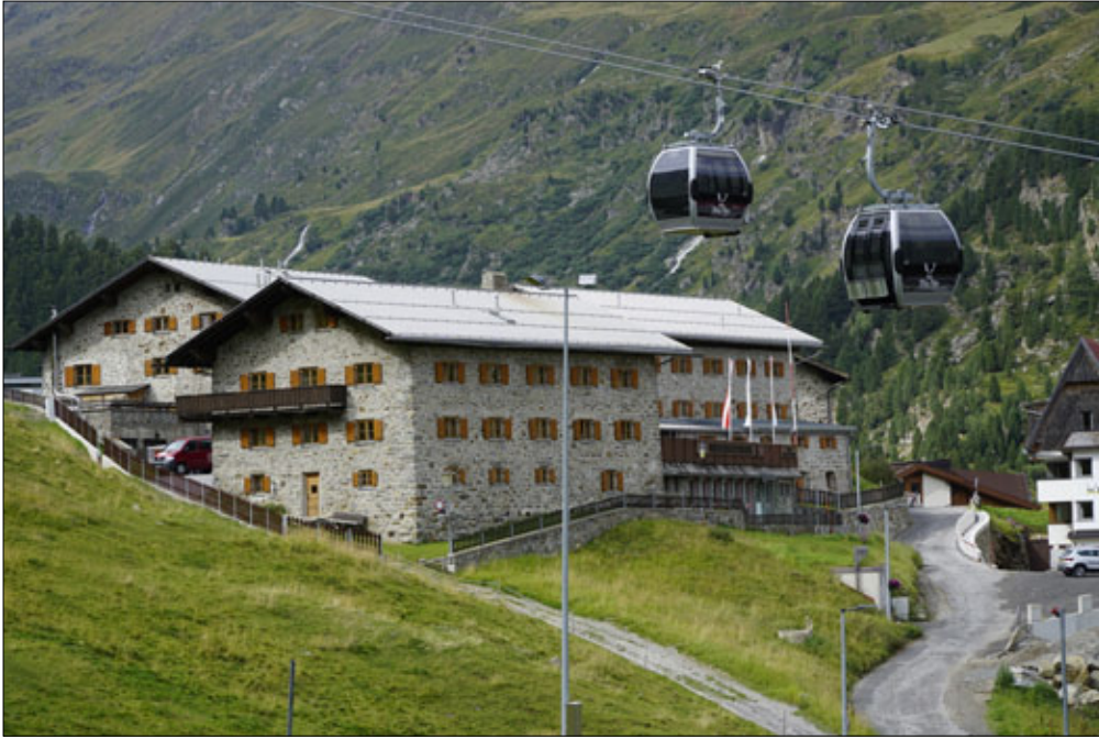
Abbildung 6 Alpine Forschungsstelle Obergurgl. Im Vordergrund schweben die Seilbahngondeln zur Hohen Mut vorbei. Universität Innsbruck Foto: F. Mandl, 2022.
