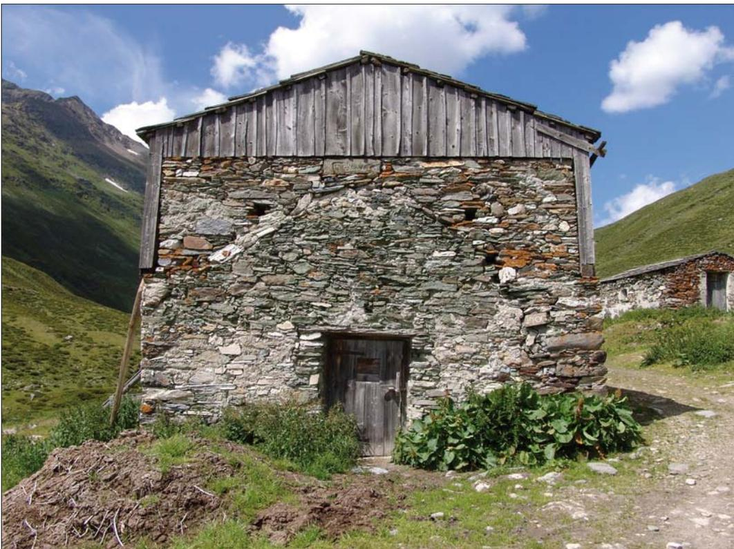
*Eine aufgestockte Hütte in der Jagdhausalm. Die erste Bauphase hat noch eine gemörtelte Steinmauer. Der Aufbau der zweiten Bauphase verwendet Ziegelfragmente. Der Türsturz besteht aus einer Steinplatte. Foto 2005. Archiv ANISA*
