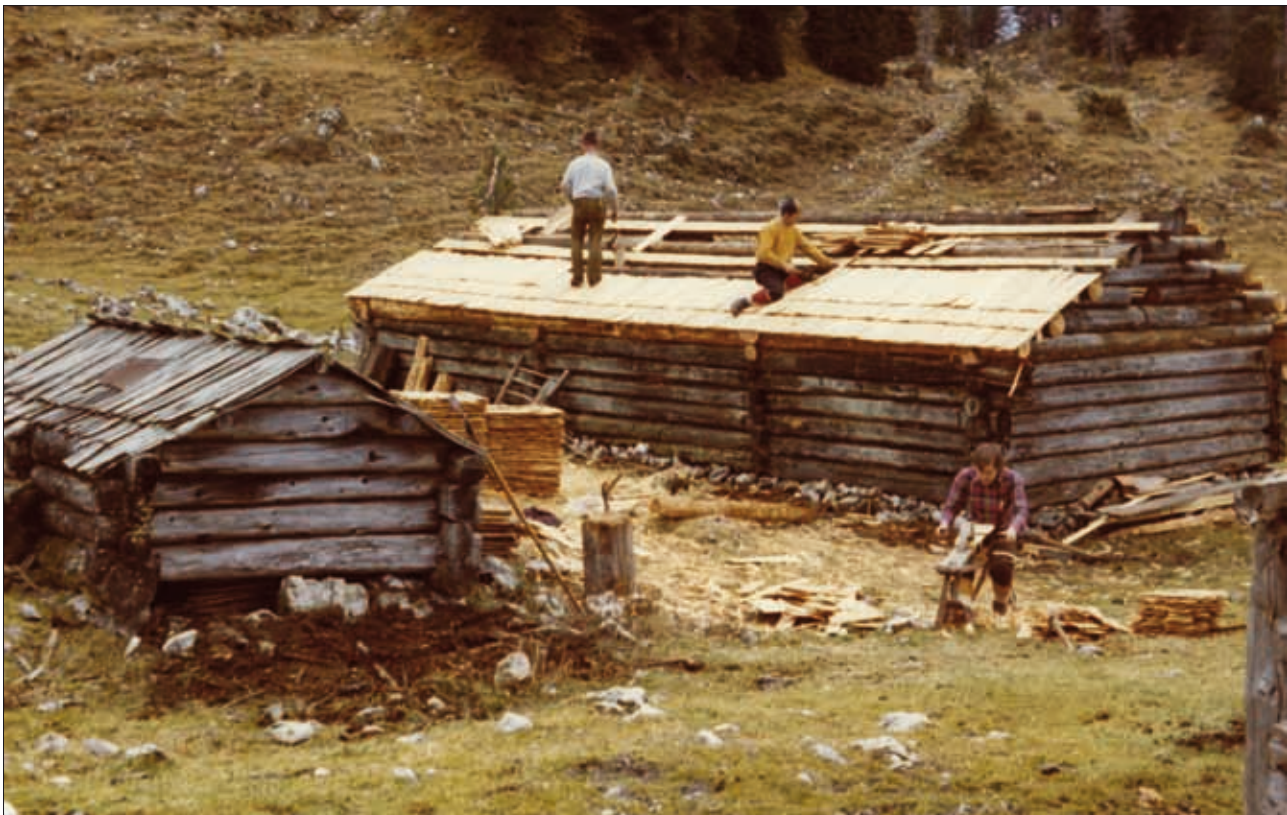
Abb. 7: Im 19. und im 20. Jahrhundert hat man zur Verbesserung der Tragfähigkeit des Daches bei Neubauten zugeschnittene Zwischenpfetten eingezogen, sodass sechs kürzere Schindellagen aufgenagelt werden konnten. Auf dem dreiteiligen „Trempe“ liegen die Pfetten viermal auf den Blockwänden auf. Das gewährt eine sehr hohe Tragfähigkeit, die wegen der Schneemassen im Winter nötig ist. (Foto: Familie Ebenschwaiger. Repro: Franz Mandl)
