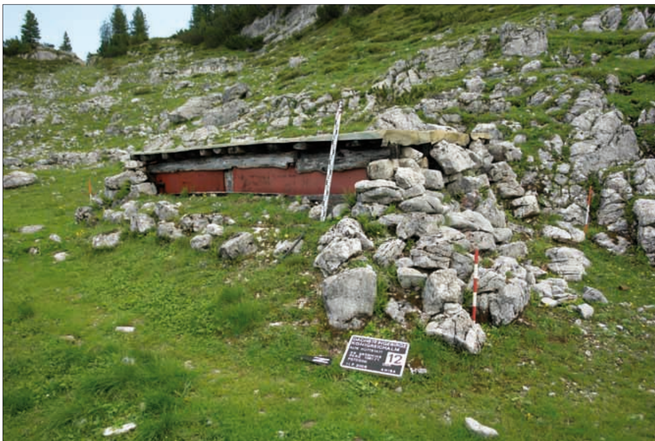
Abb. 17: Objekt 12. Bassin mit einem Fassungsvermögen von 10 \text{ m}^3
