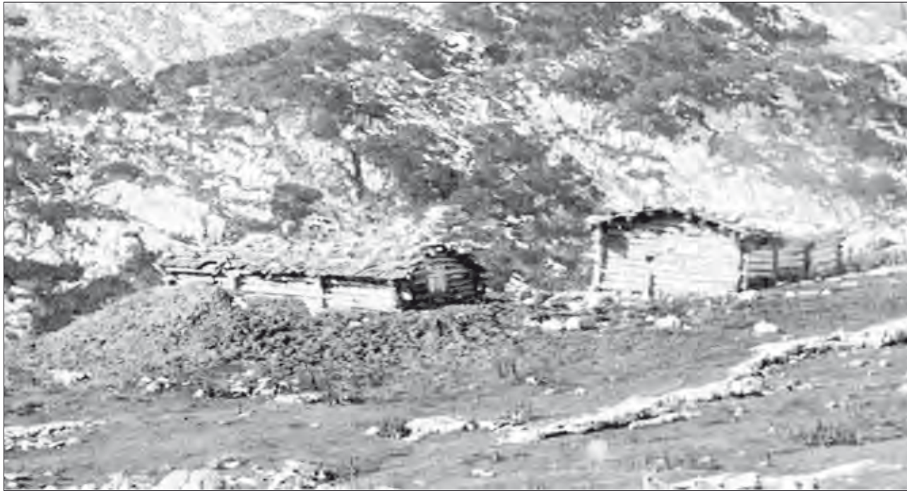
Abb. 8: Gjaidalm, Stierhütten, 1890. Der dreiteilige Trempel und die dreiteilige Hütte entsprechen dem Gröbminger Baustil. Dieses alte Foto zeigt uns den typischen, auf einem Steinfundament errichteten Blockbau mit Ansdach und Legschindeldeckung. (Foto und Repro Franz Mandl)
