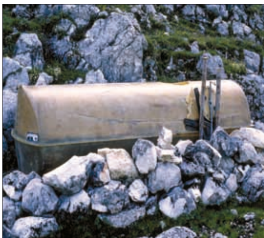
Abb. 15: Wasserbehälter aus Kunstharz auf der alten Hüttstatt der Königreichalm. Dieser durch die Schneelast beschädigte Behälter wurde später durch einen Metallbehälter ersetzt. Foto: Franz Mandl 1982
